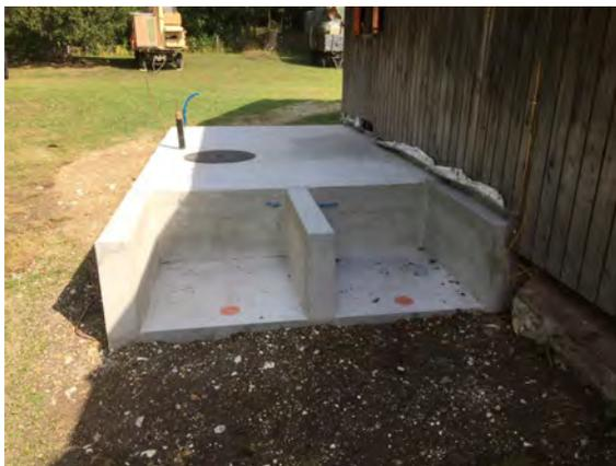
Les maçons ont commencé par creuser et bétonner les fondations dans lesquelles l'espace prévu pour les deux conteneurs mobiles est visible...
