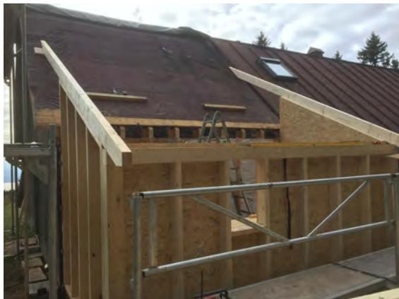
...une fois le revêtement du toit déposé, les charpentiers ont pris le relais pour poser la charpente et l'ossature des parois extérieures de l'extension contre la façade ouest...
